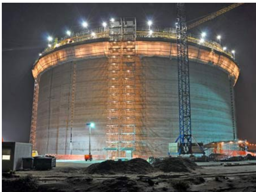
Rys 4. Zbiornik betonowy do magazynowania dużych ilości LNG
